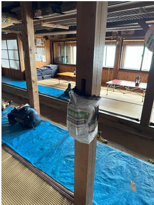
写真 5. 山小屋内の柱に設置
